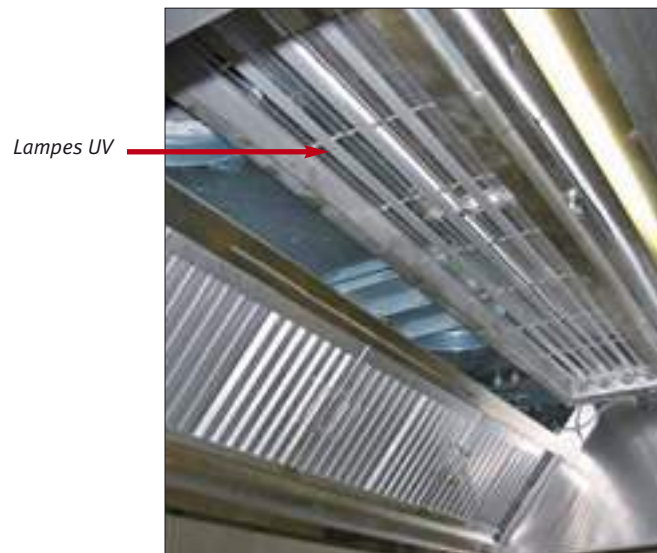
Hotte d'aspiration avec système à lampes UV.
