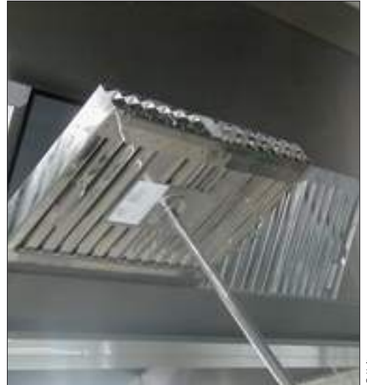
Outil de démontage/remontage du filtre en position.
